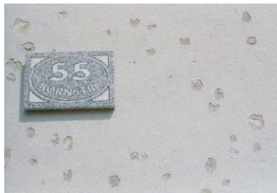
Fassade mit mineralischem WDV-System
