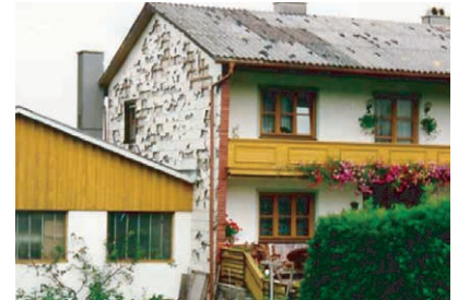
Fassade mit Faserzementplatten
