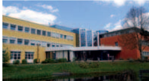
Drei überzeugende Argumente für die Aufdoppelung: Instandsetzung eines bestehenden WDVS bei gleichzeitiger Steigerung der Dämmleistung und optischer Neugestaltung des Gebäudes.
