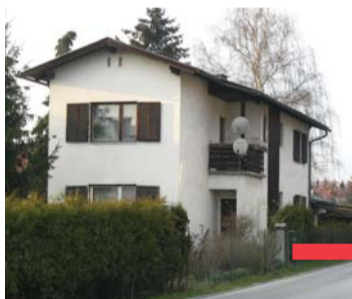
Das Haus der Familie Klüver-Pfandtner vor der Sanierung
