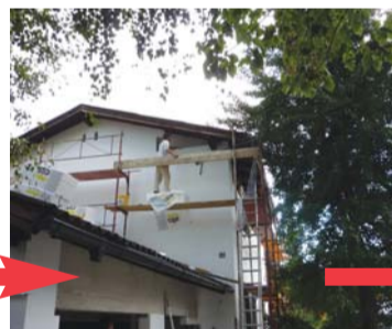
Professionalist des Sto-Qualitätspartners Westox Josef Pfundner beim Anbringen der StoTherm Vario Wärmedämmung
