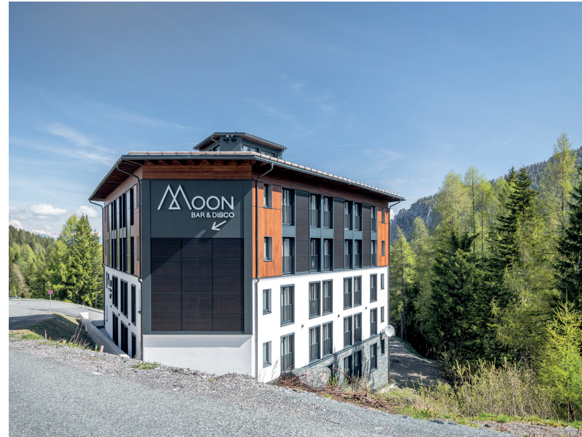
Die Integration in das Gelände des sechsstöckigen Gebäudes erforderte umfangreiche Planungen.
