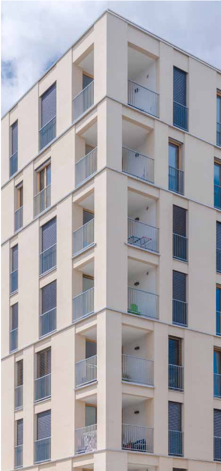
Wohnanlage Vorgartenstraße, Wien, AT Planung: BEHF Architects, Wien, AT Ausführung: Ing. A. Petutschnig GmbH, Mitterberg, AT Bauherr: BUWOG Group GmbH., Wien, AT Sto-Kompetenzen: StoTherm Vario, StoBrick Klinkerfassade Foto: Christian Schellander, artboxx, AT
