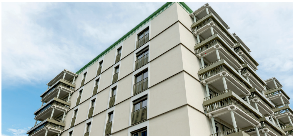
LeopoldQuartier Living Wien, UBM Developement AG , Gangoly & Kristiner Architekten ZT GmbH, Foto: Christian Schellander
