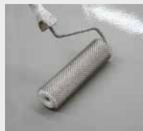
... und mittels Stachelwalze entlüftet.
