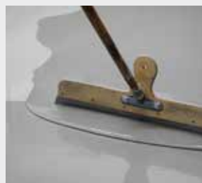
StoCrete EH 200 wird mit der Rakele aufgebracht...
