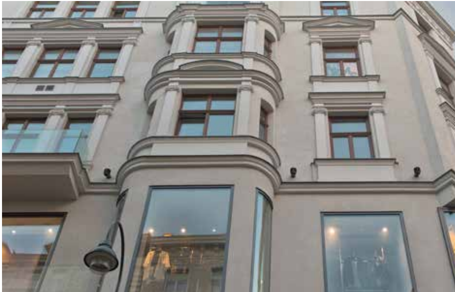
Bild links / unten: Geschäftshaus Kärntnerstraße, Wien, AT Architekt: BWM Architekten, Wien, AT Produkte: StoDeco Fassadenprofile Foto: Christian Schellander, AT
