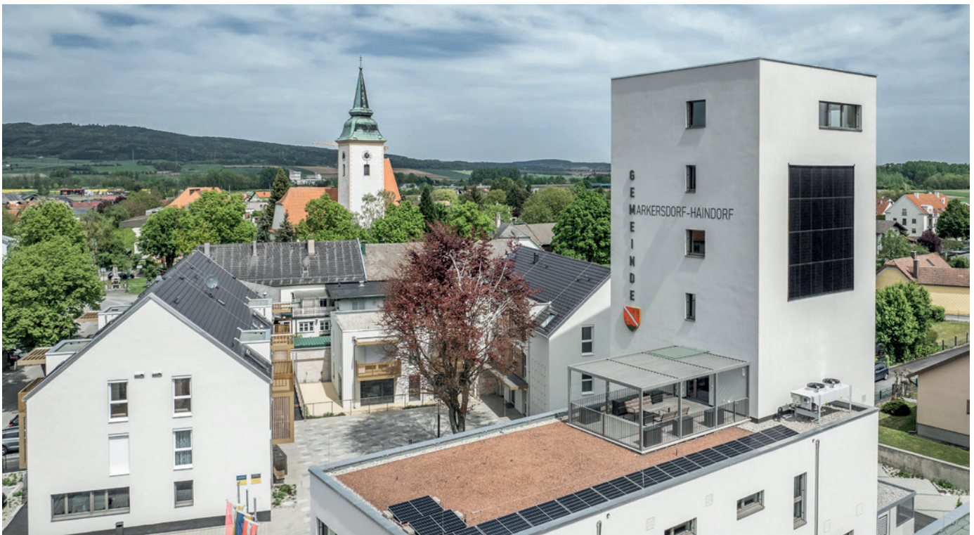
Dorfszentrum, Markersdorf, AT (Planung: Architekt Christian Galli, Krems, AT; Produkte: StoVentec Photovoltaics Inlay; Foto: Christian Schellander, artboxx)
