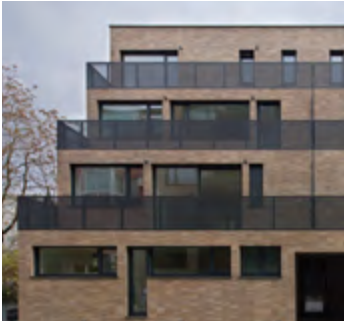
Wohnkomplex Trakoščanska, Zagreb, HR
