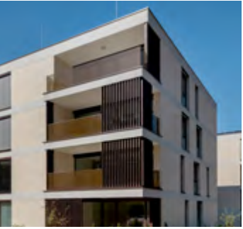
Wohnanlage am Emsbach/Hohenems, AT
