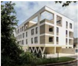
Wohnanlage Villa Murgle, Ljubljana, SLO
