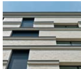
Wohnbau Keirnergasse, Wien, AT
