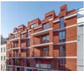
Wohnbau Murlingengasse, Wien, AT
