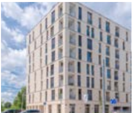
Wohnanlage Vorgartenstraße, Wien, AT
