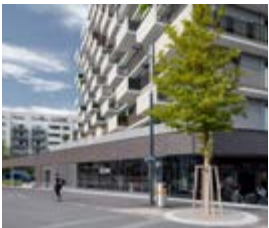
Wohnanlage Seestadt Aspern, Wien, AT
