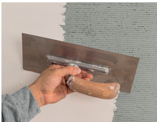
Aufbringen der Endbeschichtung
