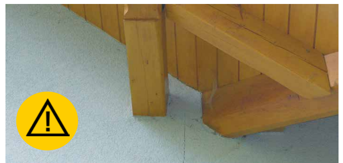
Rissbildung als Resultat einer nicht in das Wärmedämm-Verbundsystem übernommenen Gebäudedehnfuge.
