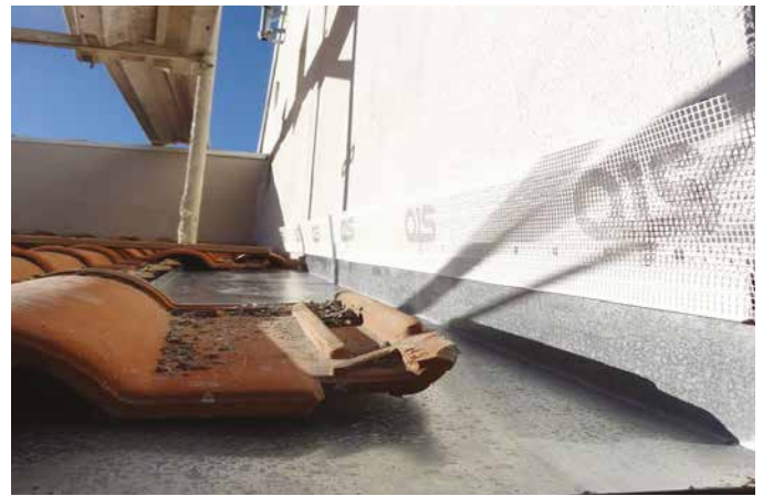
Einsatzmöglichkeit des Sto-Übergangsprofil Blech bei Blechhochzug
