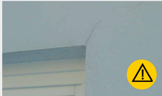
Kerbspannungsrisse aufgrund fehlender Diagonalbewehrung
