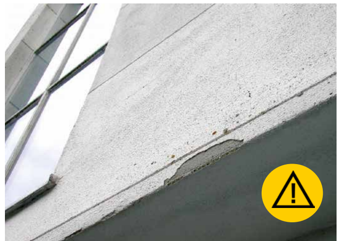
Feuchtigkeitsschaden, zurückzuführen auf eine unkontrollierte Wasserführung.
