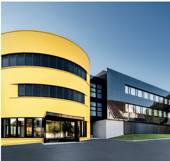
Empfangsgebäude Sto-Unternehmenszentrale, Weizen, DE Bei unserem Empfangsgebäude wurden vier verschiedene Oberflächen verwendet: Glas, Photovoltaik, Putz und plastische Fassadenelemente aus Verolith. Es handelt sich um ein Nullenergiegebäude mit DGNB-Platin-Zertifizierung. Foto: Martin Baitinger, Böblingen, DE
