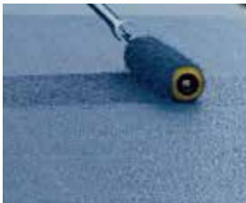
StoPox KU 614 thix wird am besten mit der Strukturwalze mittel gleichmäßig im Kreuzgang gewalzt
