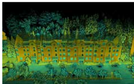
Aus dieser 3D-Laserpunktwolke entstehen die detailgenauen 3D-Modelle der Bestandsfassade ...
