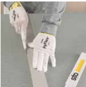
Einfaches Zuschneiden – mit Cuttermesser oder Säge
