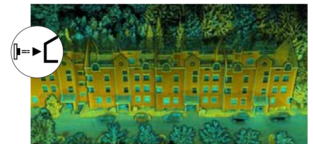
Digitale Bestandsaufnahme mit StoCapture. Erfassung von Bestandsfassaden mit mobilem LiDAR-Scanner
