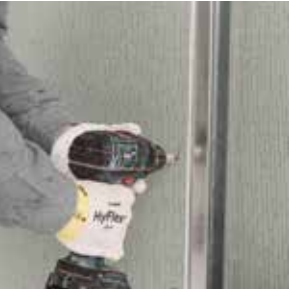
Befestigung mit Edelstahlschrauben auf Metall- oder Holzunterkonstruktion
