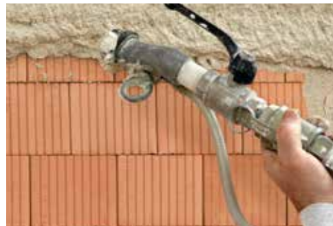
Aufbringen des Unterputzes auf das Mauerwerk
