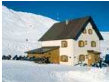
Baujahr 1968: Das erste StoTherm Classic Testhaus „Golm“ steht in 1.950 m Höhe im Montafon
