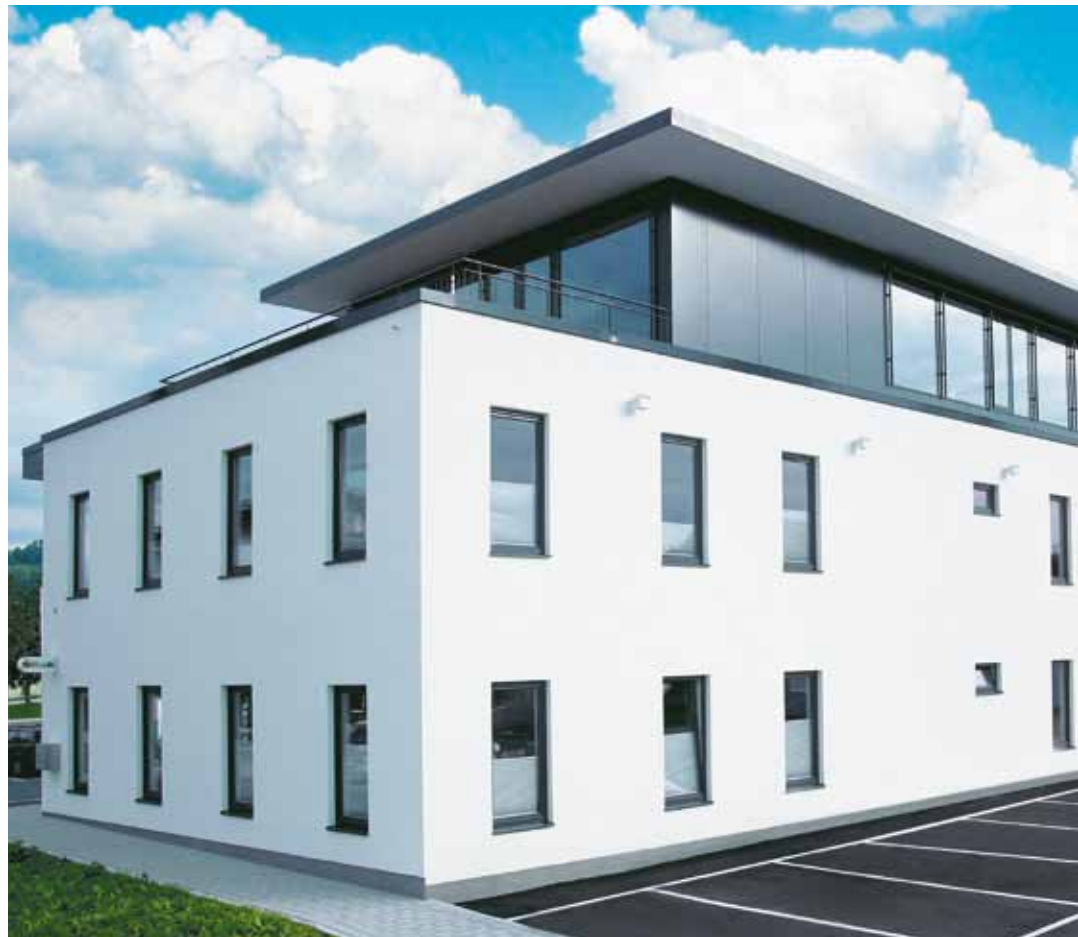
Geschäftsgebäude Firma Handlechner / Eugendorf bei Salzburg
